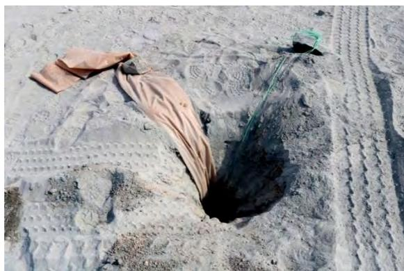
**Рисунок 1. – Скважина, подготовленная к зарядке**
