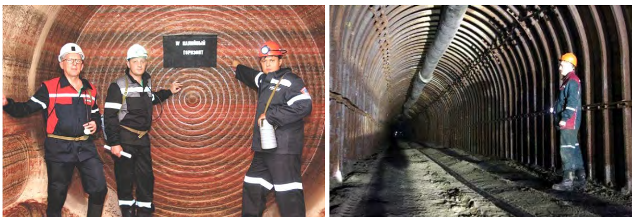
Рисунок 4. – Вскрытие IV калийного горизонта
