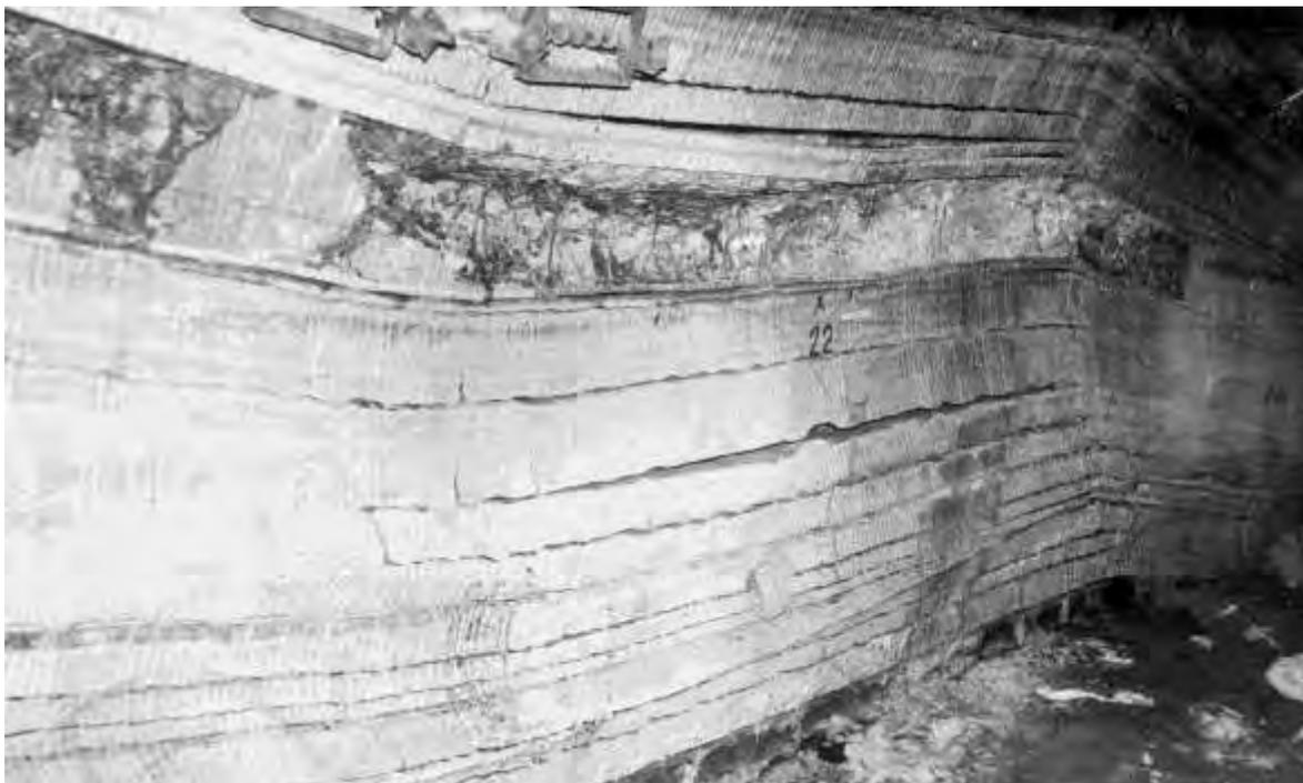
**Рисунок 1 – Зона сдвижения толщи пород с образованием техногенных трещин, наблюдаемая по стенке исследовательской выработки Первого калийного горизонта на высоте 65 м над выработанным пространством лавы № 6 Второго калийного горизонта (фото 1989 г.)**
