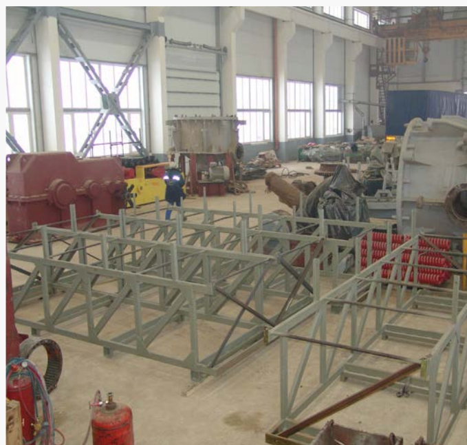
Металлоконструкции зоны Б
