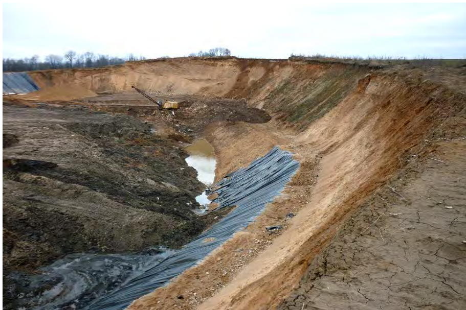
Рисунок 3. – Утилизация экскавируемого грунта от ТПМК в отработанный песчано-гравийный карьер
